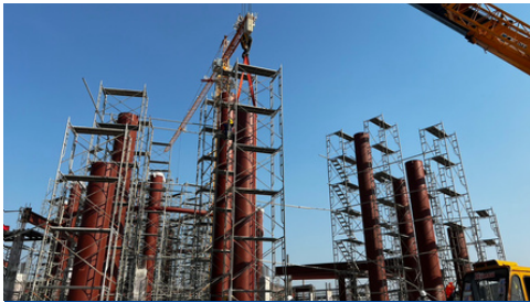
งานโครงสร้างโรงงานขนาดใหญ่
