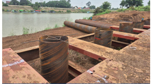
งานสะพานข้ามแม่น้ำแม่น้ำเจ้าพระยา จ.อ่างทอง
